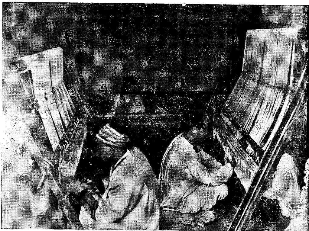
OPERATION PREPARATOIRE AU TISSAGE : MONTAGE DE LA CHAINE
