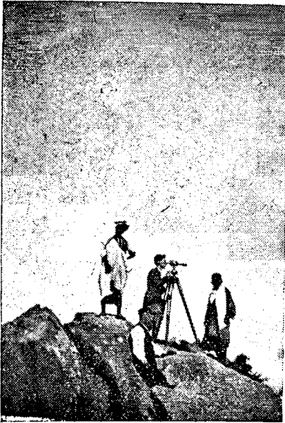
Fig. 4. — Topographe en station sur un point géodésique (tachéomètre à limbres visibles)
