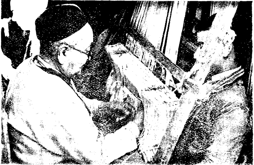
Passage des fils de chaîne dans les mailles des lisses
