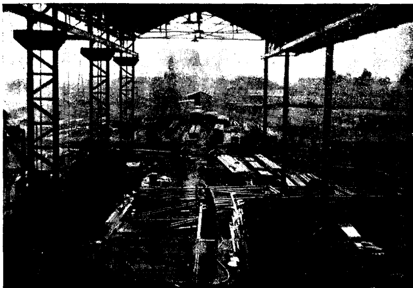
Vue d'un atelier de consruction de charpentes métalliques
