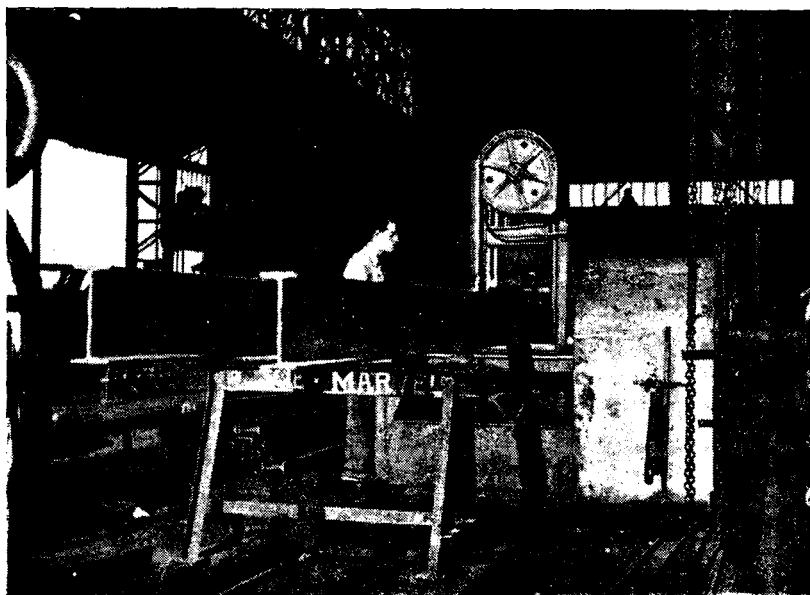
Vue d'un atelier de constructions métalliques
