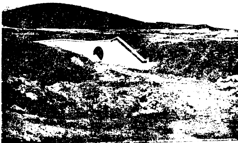
Photo 8. — Entrée du souterrain de Pont-de-Trajan
