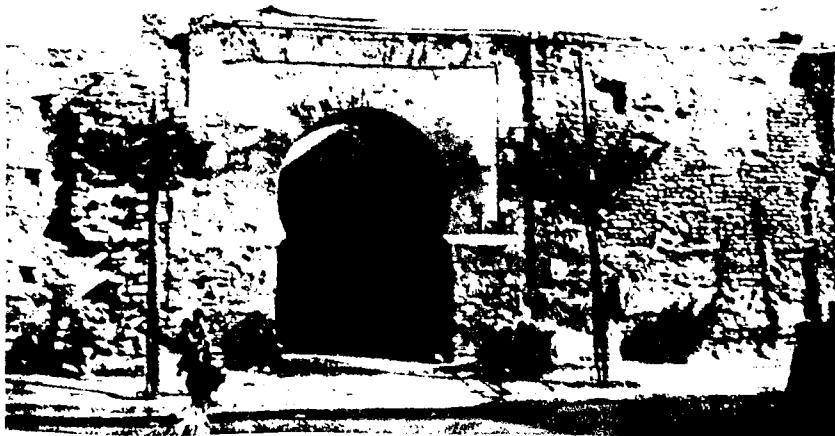
Fig. 2. — Bab-Djedid. Porte datant du XIII e siècle (à gauche, on remarque les adhérences d'une ancienne tour)
