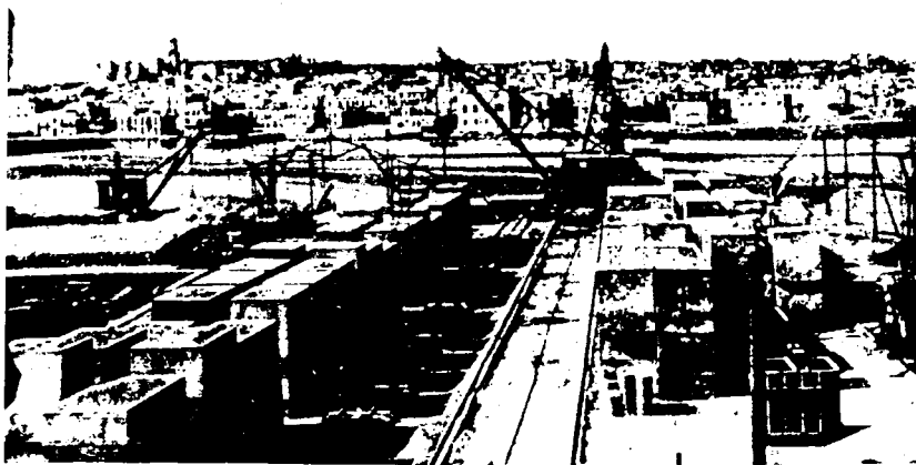
(Fig. 6). — Parc à blocs établi pour la reconstruction du port de Sousse
