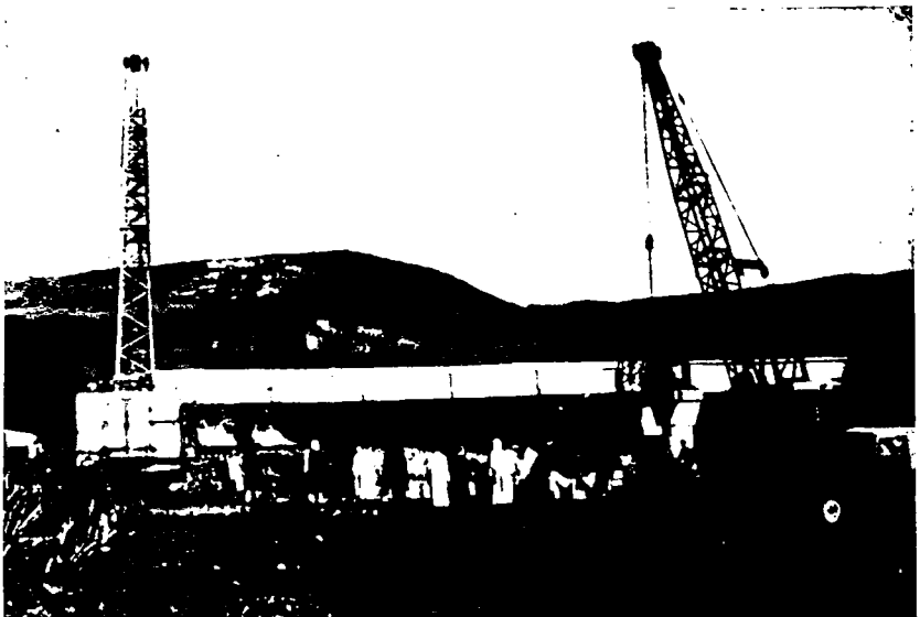
Fig. 10. — Pose d'une poutre au moyen de deux grues sur chenilles
