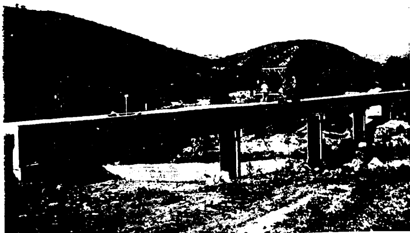
Fig. 8. — Pont sur l'Oued el Lil. On pose la conduite
