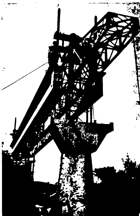
Fig. 11. — Pose simultanée de deux demi-poutres au moyen de la passerelle de lancement
