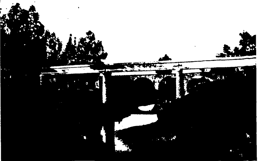
Fig. 2. — Pont sur l'Oued Zerga
