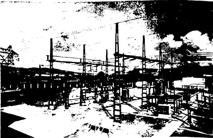
Les installations du poste de transformation de Tadjerouine
