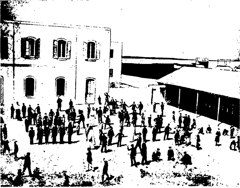
Fig. 9. — La cour intérieure du Collège St Charles en 1884 (au fond, à droite les gazomètres et le lac de Tunis)
