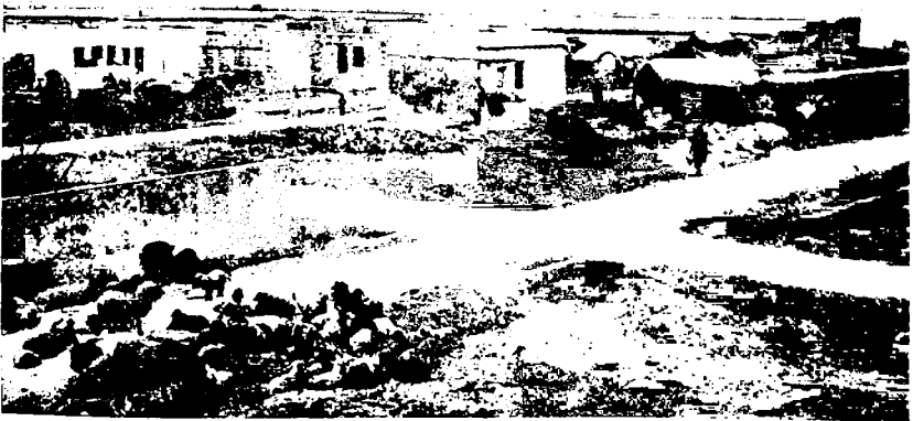
Habitat musulman à Mégrine (près Tunis). Des maisonnettes modernes remplacent les gourbis en pisé
