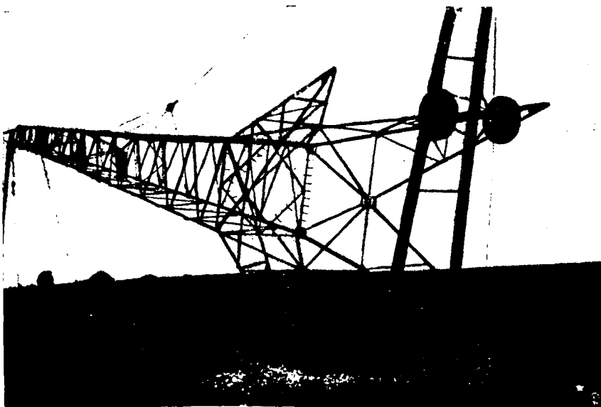
Mise en place d'un pylone de la ligne 90 kv Nebeur-Tunis
