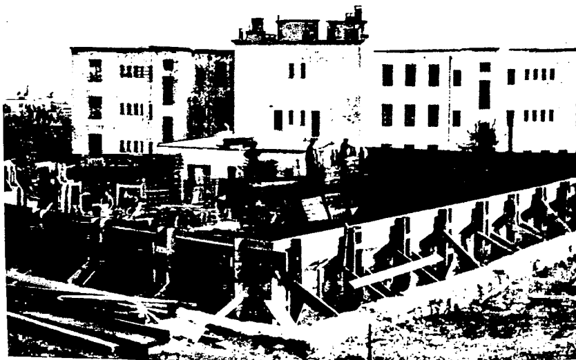
Construction de la piscine du Collège Technique Emile Loubet de Tunis
